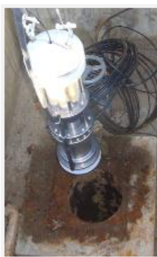
B. nano 発生装置Foamestを搭載した井戸洗浄用マイクロ・ナノバブル発生装置
